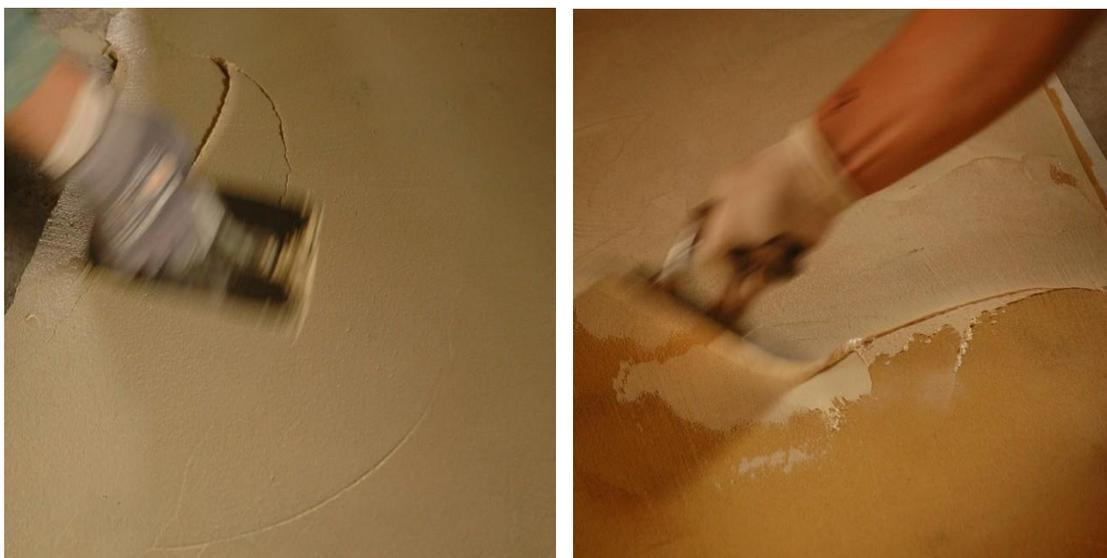
**2ª camada de acabamento.** É feito aplicando uma demão de MICRO LIME PLUS SUPERFINE. O superfino é inserido nos poros do Micro Lime Plus deixando um acabamento que chamamos de POLIDO.
